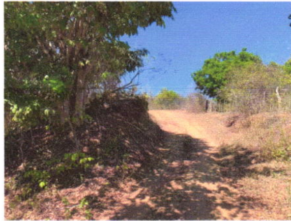
Visão geral da via
