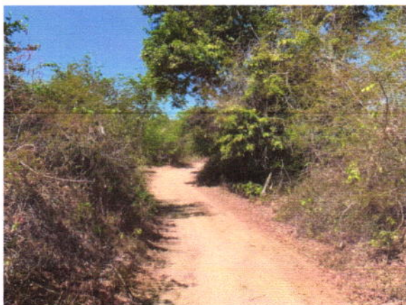
Visão geral da via
