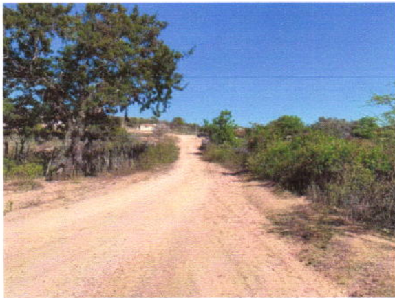
Visão geral da via
