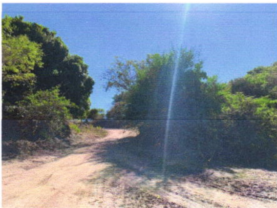
Visão geral da via
