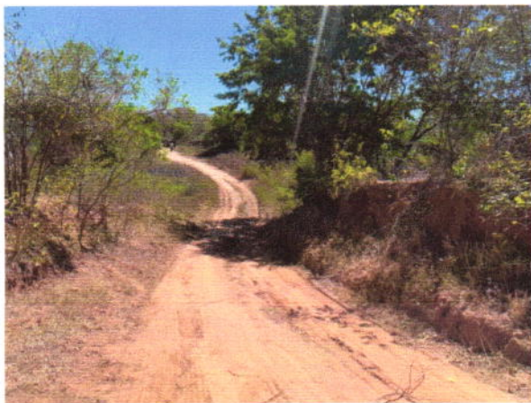
Visão geral da via
