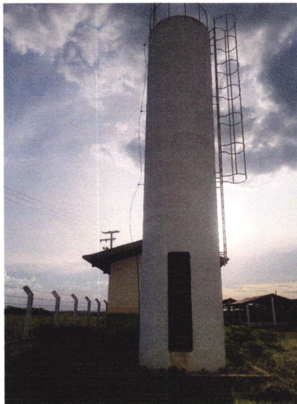
FOTO -06 (RESERVATÓRIO ELEVADO)
