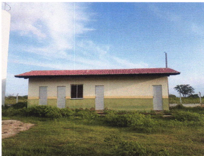
FOTO -02 (BANHEIROS / VESTIÁRIOS)
