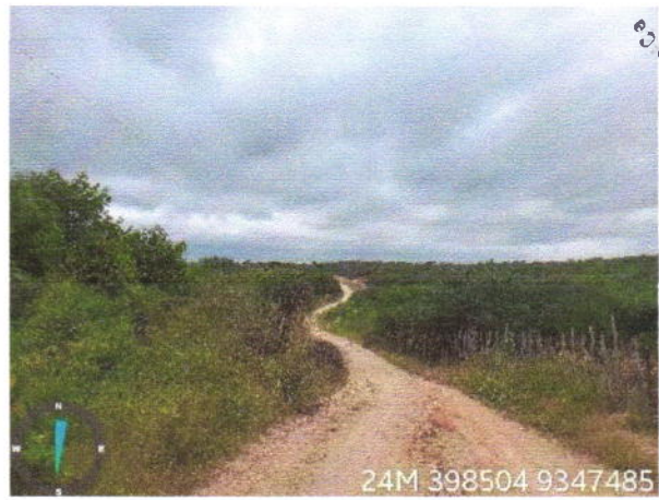
Visão geral da via
