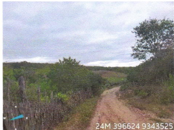
Visão geral da via
