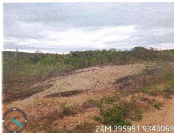
Visão geral da via
