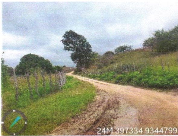
Visão geral da via
