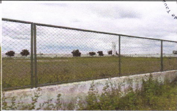
Gradil de proteção do estádio
