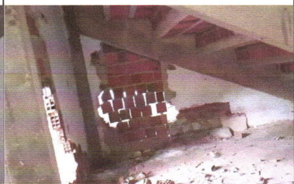
Vista inferior da arquibancada
