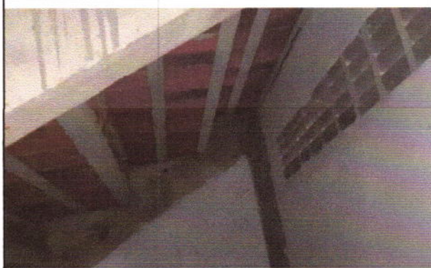
Vista inferior da arquibancada
