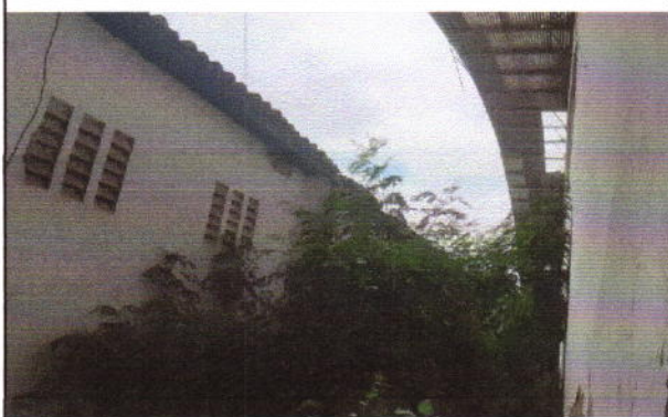
Cobertura do ginásio
