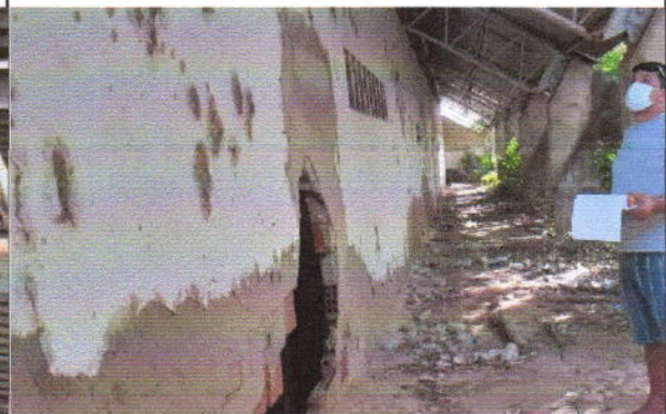
Vista da parede externa/corredor
