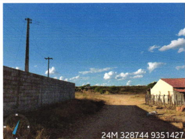
Final do Trecho CE-187 - Localidade de Santo Antônio
