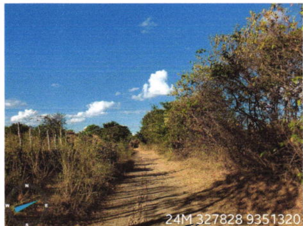
Visão geral da via
