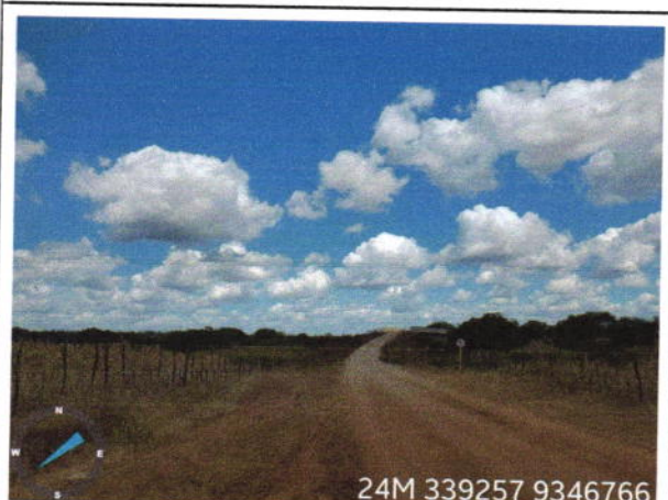
Visão geral da via
