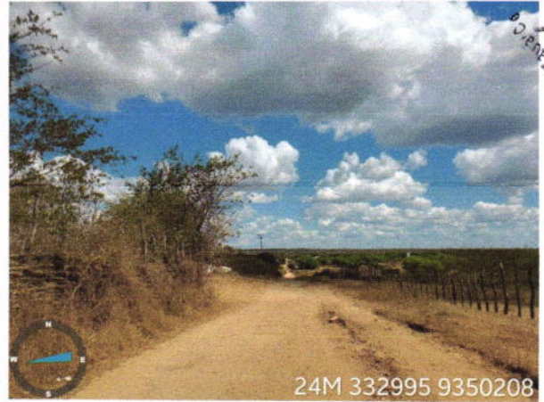
Visão geral da via
