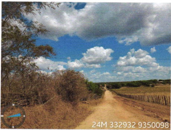
Visão geral da via
