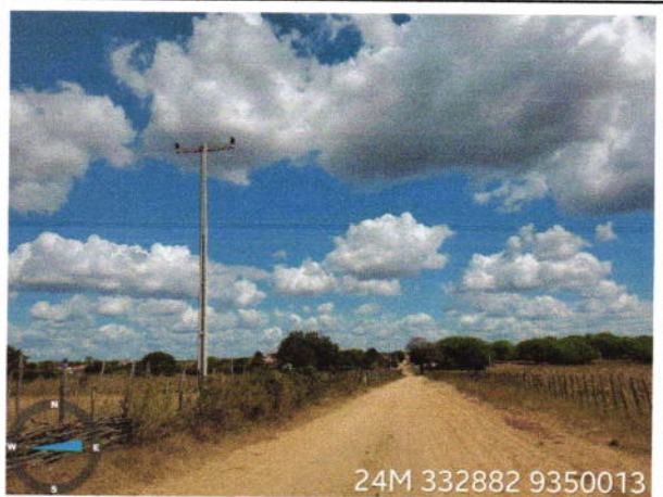
Visão geral da via
