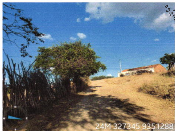
Visão geral da via
