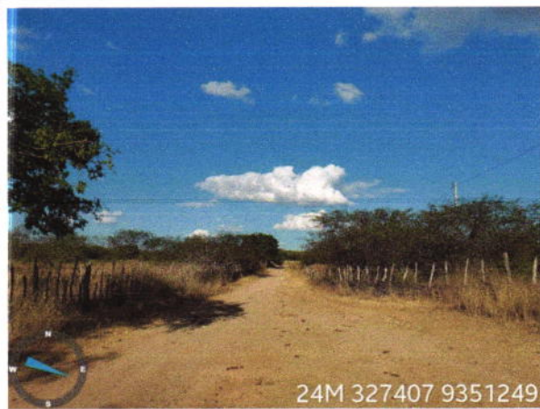
Visão geral da via
