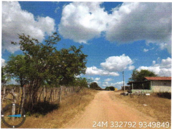
Visão geral da via
