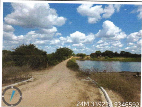
Visão geral da via
