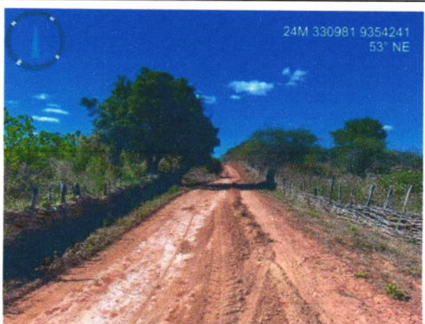
Visão geral da estrada
