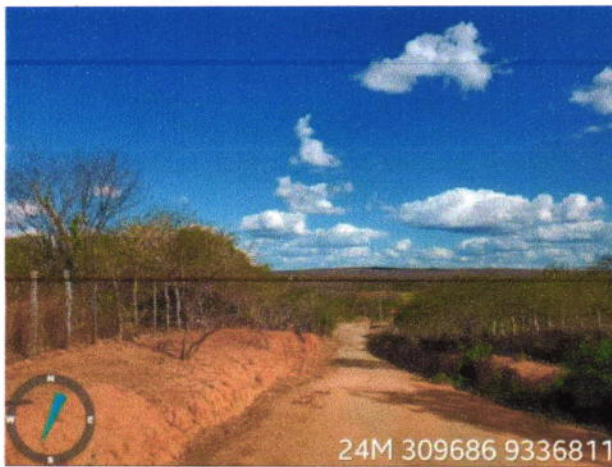
Visão geral da estrada
