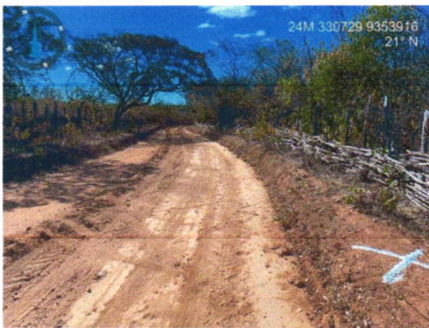
Visão geral da estrada
