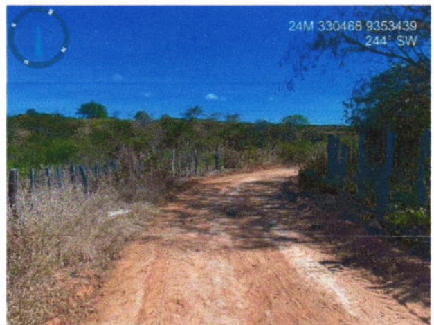
Visão geral da estrada
