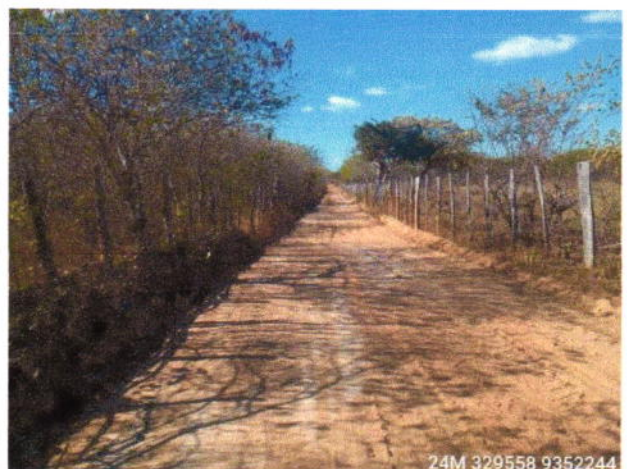
Visão geral da estrada
