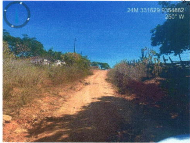
Visão geral da estrada
