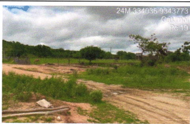
Vista geral da estrada
