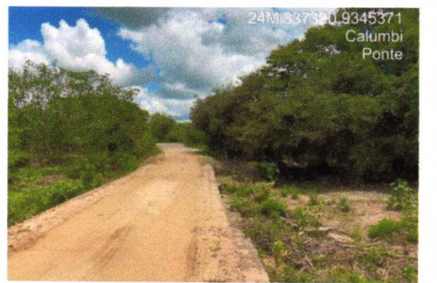
visão geral da estrada sobre passagem molhada
