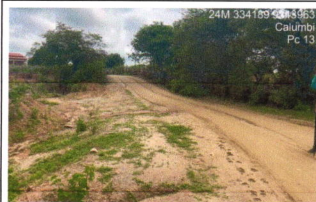
Vista geral da estrada
