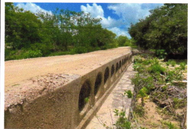
visão geral da estrada
