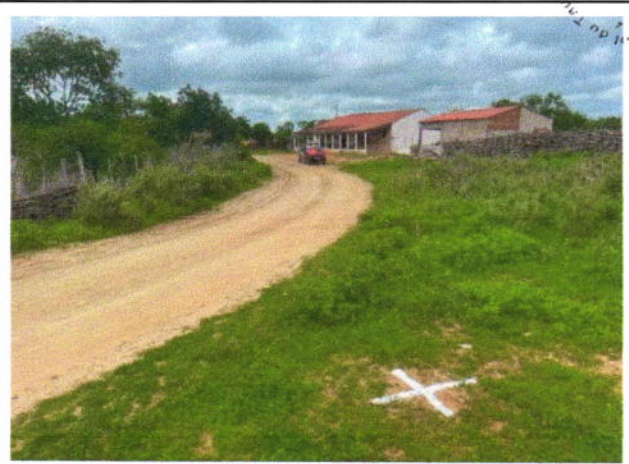
Visão geral da estrada
