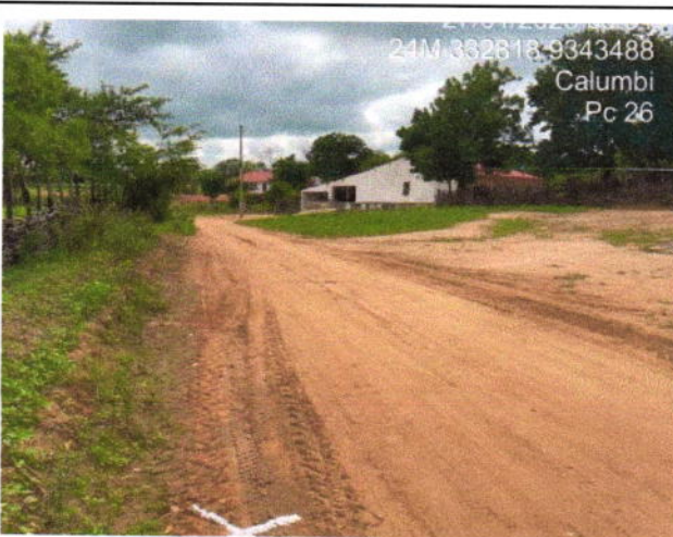
Vista do trecho
