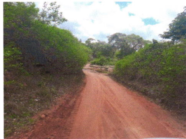
Vista do trecho próxima a passagem molhada projetada
