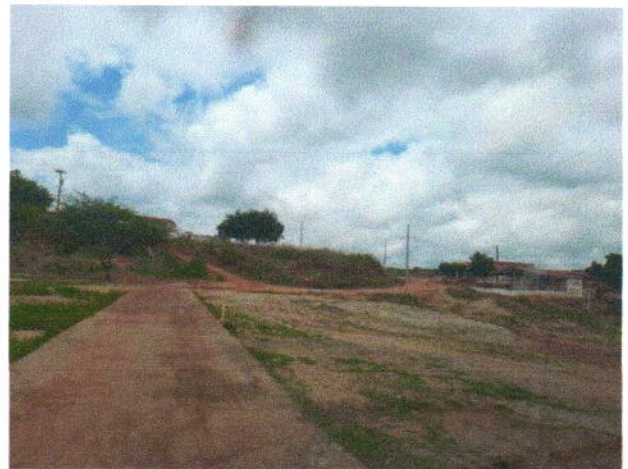
Vista do Sangradouro do Açude Santa Tereza
