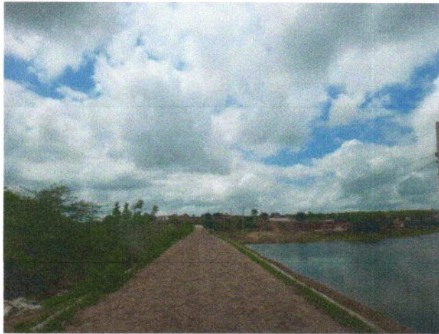
Vista do início do Trecho em Santa Tereza
