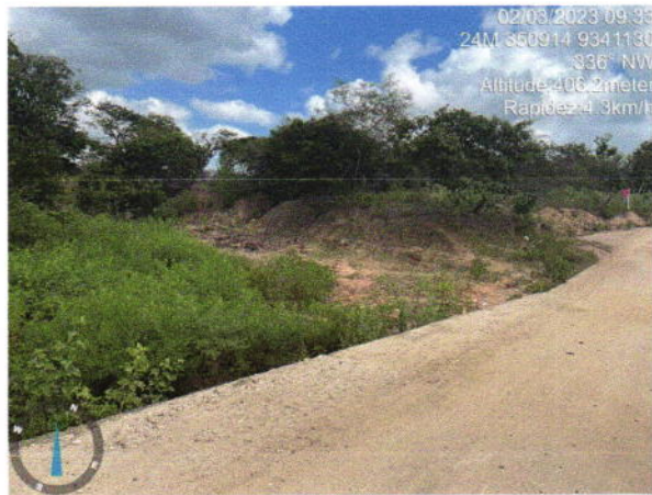
Vista da passagem a ser demolida para implantação de uma passagem molhada que comporte a vazão
