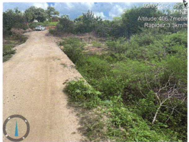
Vista da passagem a ser demolida para implantação de uma passagem molhada que comporte a vazão
