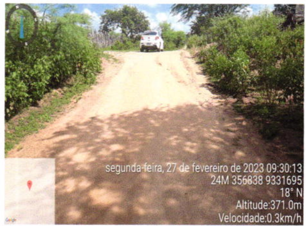
Visão geral do local a implantar a passagem molhada
