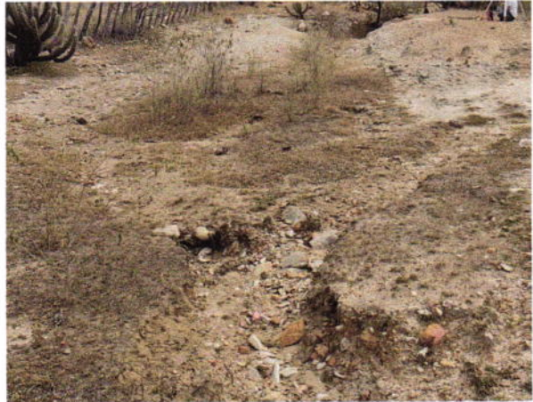
Visão da erosão causada pelo riacho do Camará
