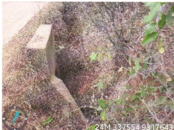
Visão sobre bueiro
