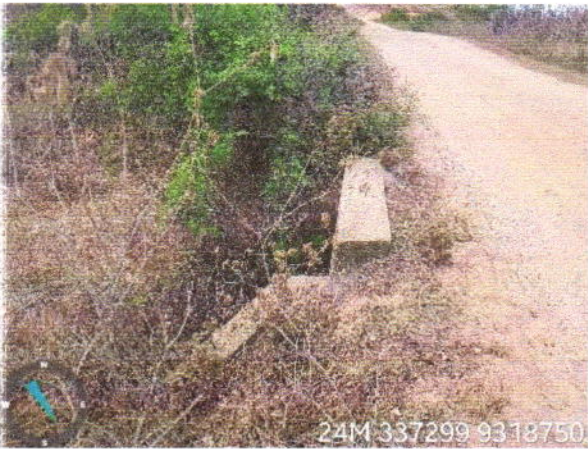
Visão sobre bueiro
