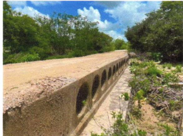
Visão da Passagem existente
