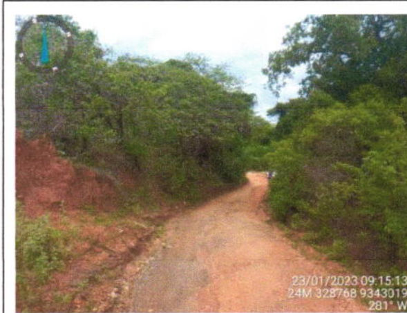
Visão da Passagem final do trecho
