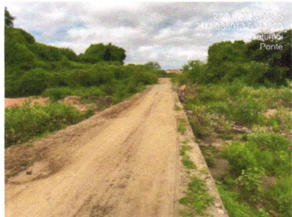
Visão da Passagem final do trecho
