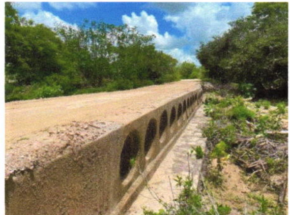
Visão da Passagem a ser demolida
