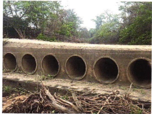
Visão dos tubos a demolir
