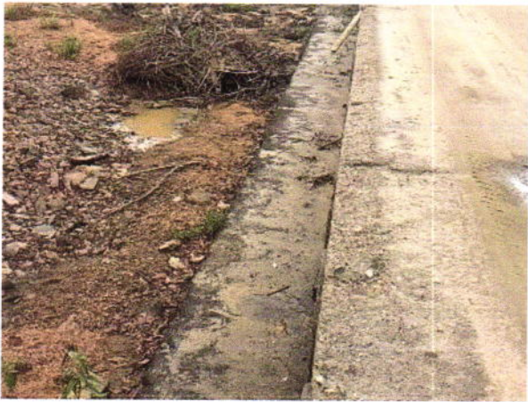
Visão da calçada a jusante a demolir
