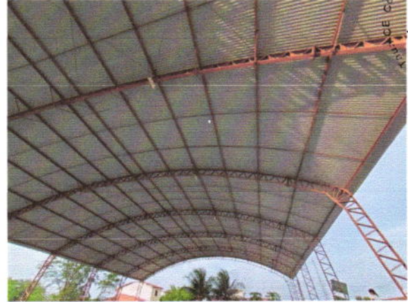
Detalhe Estrutura Metálica
