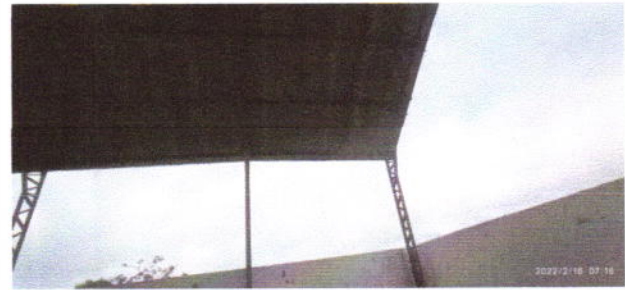
Detalhe Estrutura Metálica
