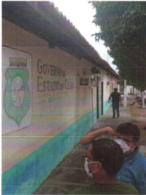
Visão Muro Externo
