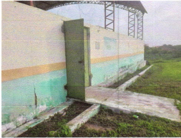
Acesso a quadra
