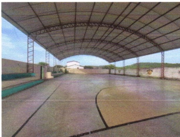
Visão Geral - quadra e arquibancada
