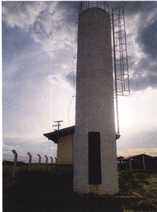
FOTO -06 (RESERVATÓRIO ELEVADO)
