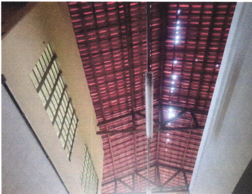
FOTO -08 (TELHADO DA INDÚSTRIA)
