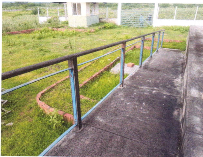
FOTO -09 (SUBSTITUIR CORRIMÃO)
