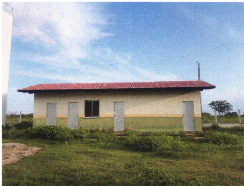
FOTO -02 (BANHEIROS / VESTIÁRIOS)
