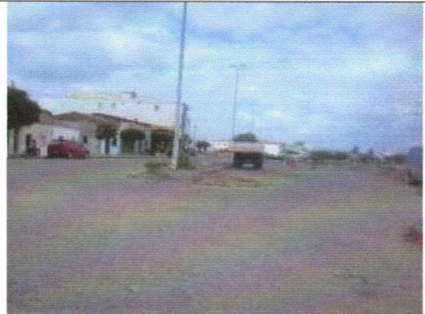
Visão Geral da Rua que contorna a praça.
